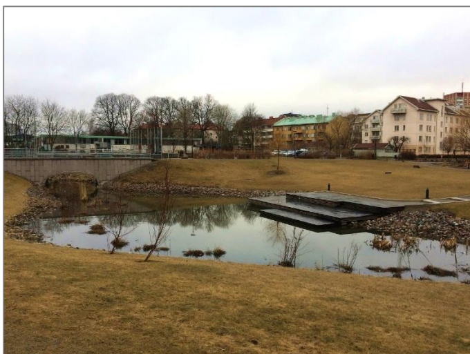
Figur 6-1. Exempelbild av en dagvattendamm i Stockholm. Foto: Geosigma.
