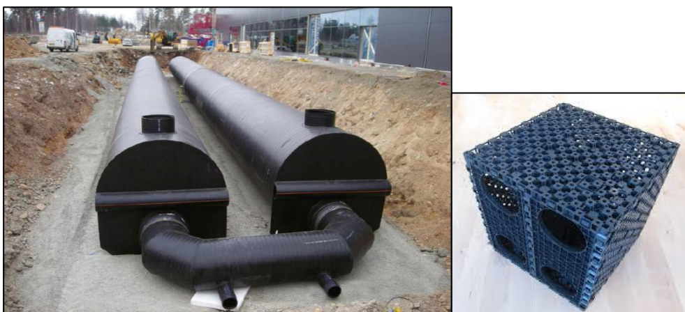
Figur 6-7. Fördröjningsmagasin i plast, i form av rörmagasin (vänster) och plastkassetter (höger).
