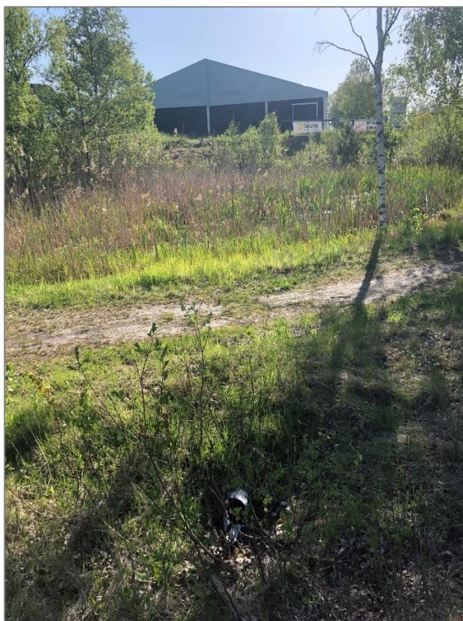
Figur 5. Ett rör som leder dagvatten från grönområdet väster om stigen till dammen.
