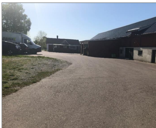
Foto 2. En asfalterad parkeringsyta lutar mot en lågpunkt vid den befintliga bilverkstadsbyggnaden.
