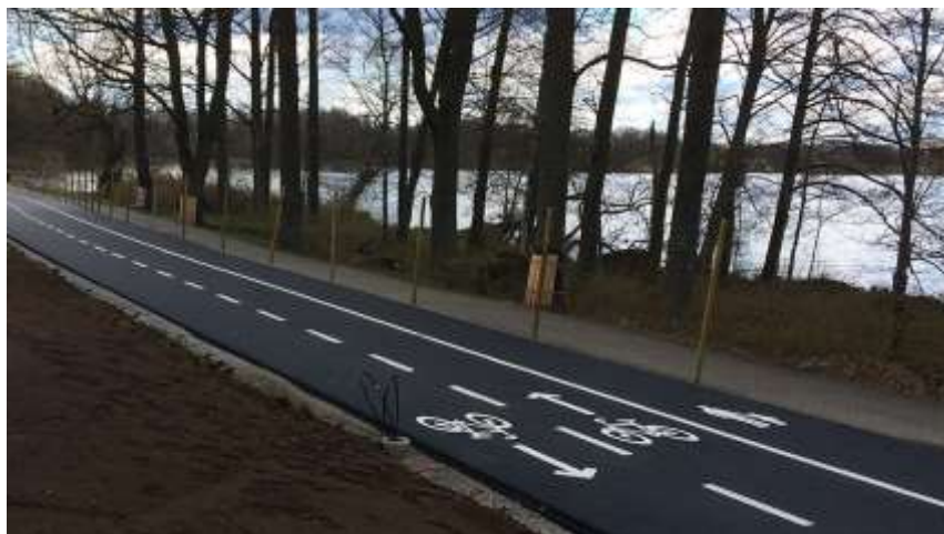
Figur 3.5. Principiell körfältsdisposition för en dubbelriktad supercykelbana. Foto: Växjö kommun.
