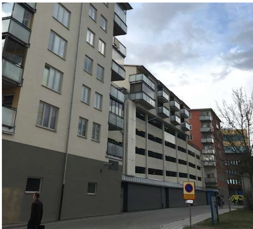
Figur 5.1. Parkeringshuset Grimhild i Uppsala byggdes på 1960-talet med den tidens krav på form och funktion och fick 2002 ett skal av nya lokaler för verksamhet och bostäder runt om samt radhus ovanpå.
