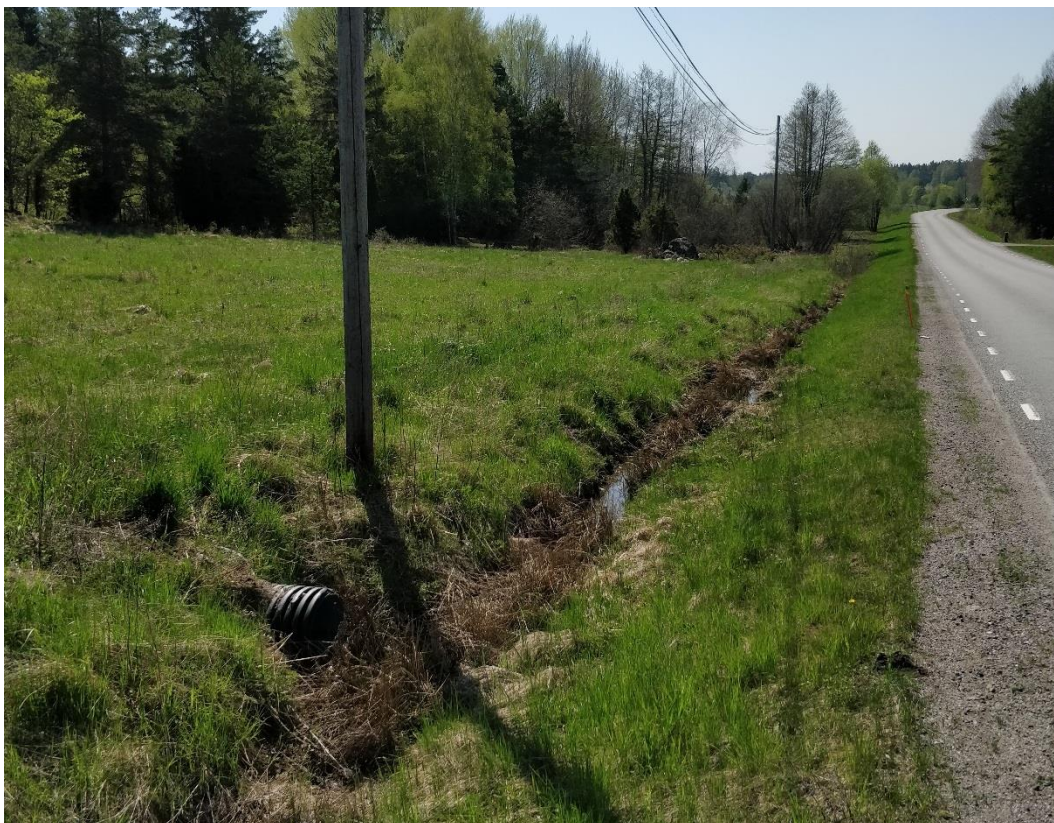
Figur 6: Dike som avvattnar den norra delen av utredningsområdet längs den östra sidan av Björkkällevägen.
