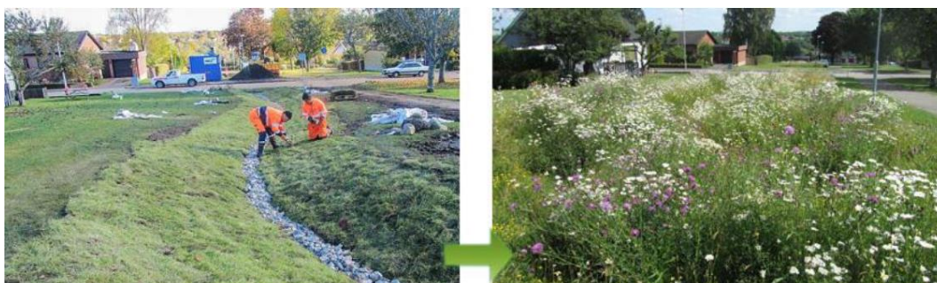
Figur 20. Exempel på hur ett större svackdike kan utformas. Figuren är hämtad från VegTech.
