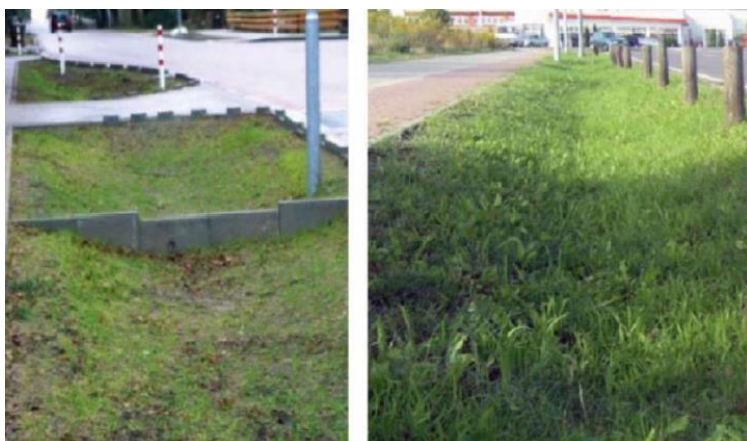
Figur 19. Exempel på hur gräsbeklädda diken kan utformas. Bilderna kommer från Stockholm Vatten och Avfall.
