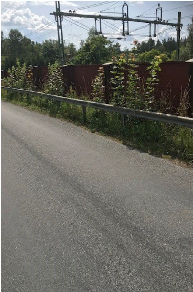
Figur 9. Bullerskärm mellan Boängsvägen och Ostkustbanan.
