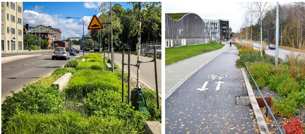
Figur 21. Till vänster: Nedsänkt regnbädd längs Strandbodgatan i Uppsala. Dagvatten från körbanan leds in via släpp i kantsten. Dagvatten från gång- och cykelbanan leds in på bred front över nollad kantsten. Bildkälla: Baramineraler.se Till höger: Nedsänkt regnbädd i Rosendal, Uppsala, med inloppskar som sprider vattnet i bädden. Bildkälla: Edge.
