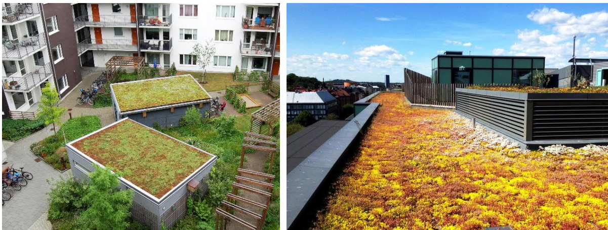
Figur 19. Gröna tak fördröjer och reducerar mängden dagvatten samt bidrar med grönska och biologisk mångfald. Till vänster. Miljöhus, Malmö. Bildkälla: Vegtech. Till höger. Takpark, Stockholm. Bildkälla: WRS.
