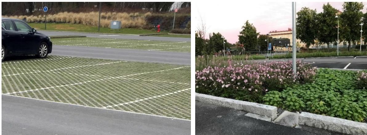
Figur 20. Till vänster: Genomsläpplig beläggning på parkeringsyta. Bildkälla: VA SYD. Till höger: Dagvatten från parkeringsyta leds ut i växtbädd via släpp i kantsten. Bildkälla: WSP
