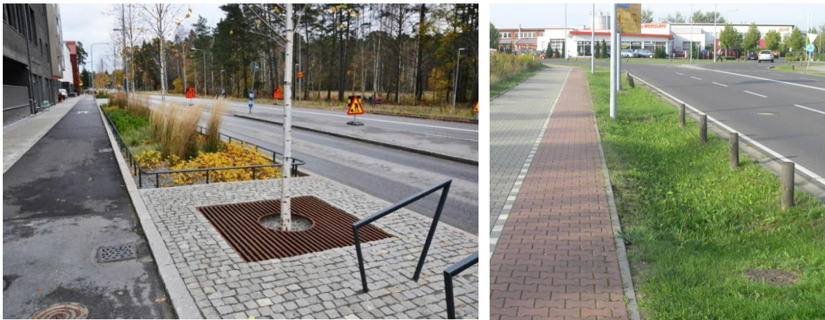
Figur 22. Till vänster: Skelettjord med träd i gatumiljö från Rosendal, Uppsala. Dagvattnet leds in via gallerbrunn. Bildkälla: Edge. Till höger: Infiltrationsstråk i gatumiljö. Bidrar med flödesutjämning och hög rening. Bildkälla: Stockholm Vatten och Avfall
