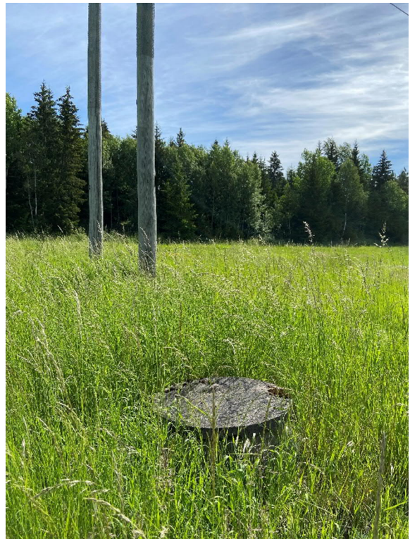
Figur 11. Till vänster. Trumma ut mot åkermarken, vid kraftledningsgatan parallellt med E4:an. Till höger. Anslutande betongbrunn mitt ute på åkern.
